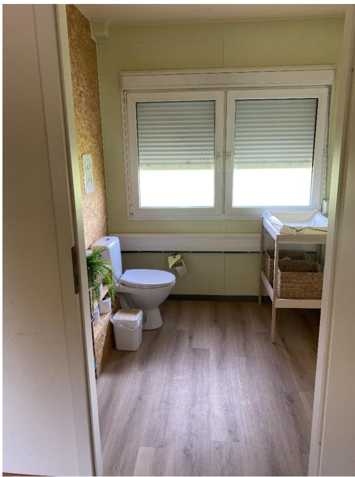
WC mit rollstuhlgängig mit Wickeltisch
